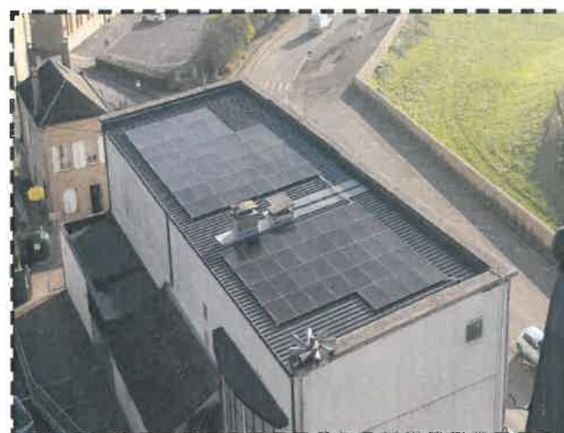
Rénovation toiture salle des fêtes et pose de panneaux photovoltaïques
